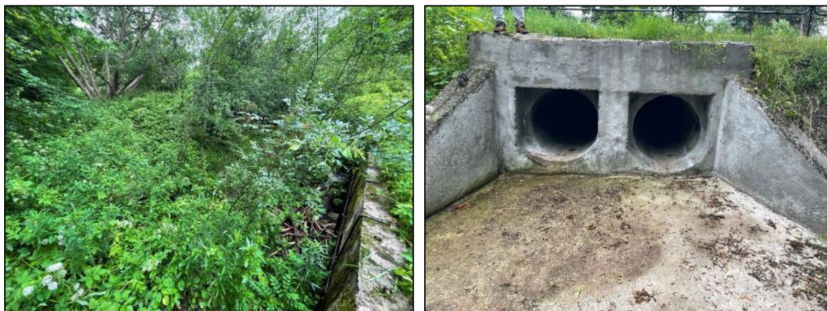
Pilt 3. Krookuse tn 8 kraav ja truubi sissevool ning Posti tn truubi väljavool.
