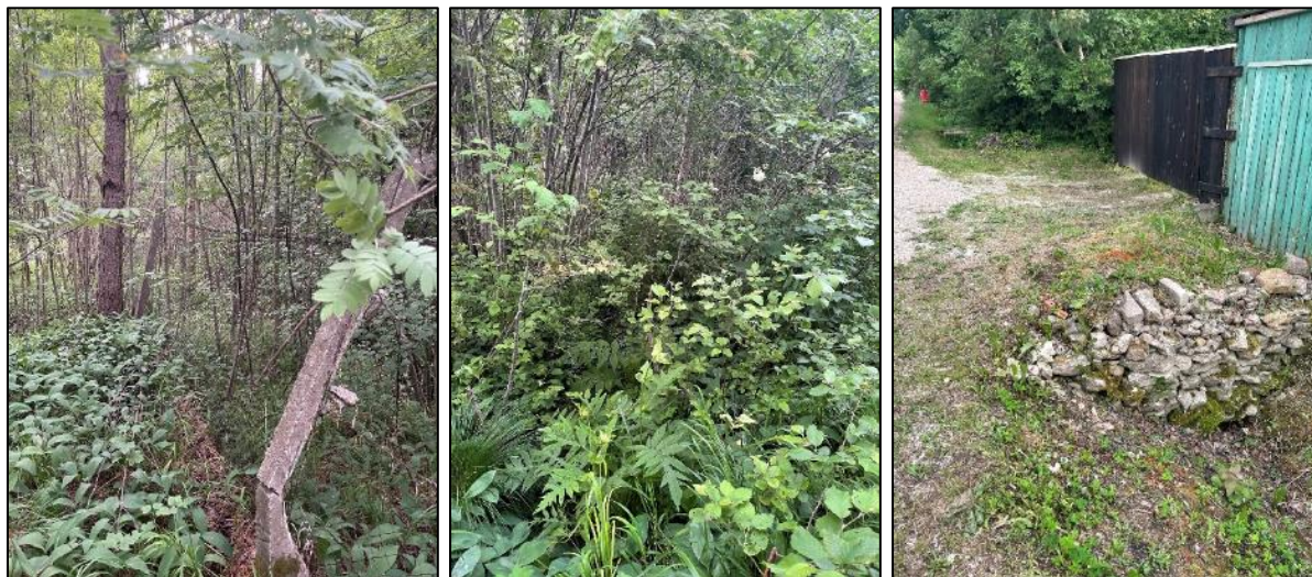
Pilt 10. Aespa aleviku välispiiril võsastunud väljavoolukraav ja Puraviku tn kinni aetud truup.
