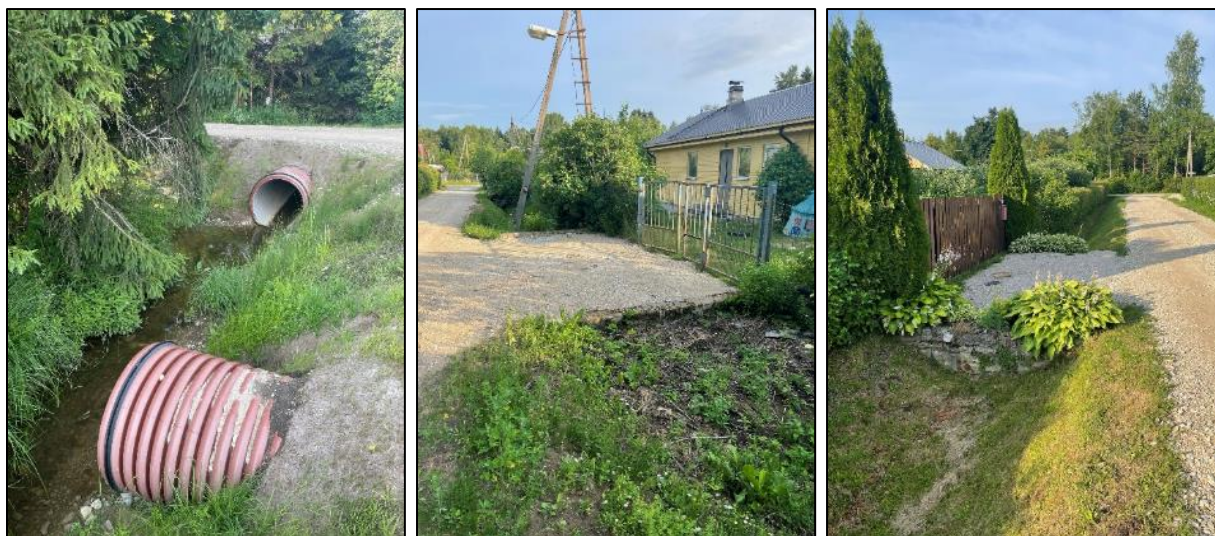
Pilt 5. Uputatud truup ja võsastunud kraav Tagakuusiku tn ja K22-K21 valgala ühendav aladimensioneeritud truup.
