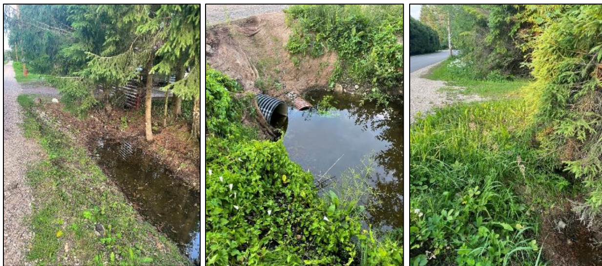
Pilt 9. Optimisti tn suletud truup, Kraavihalli uputatud truup ja Kvartsi tee kraavis kasvavad okaspuud.
