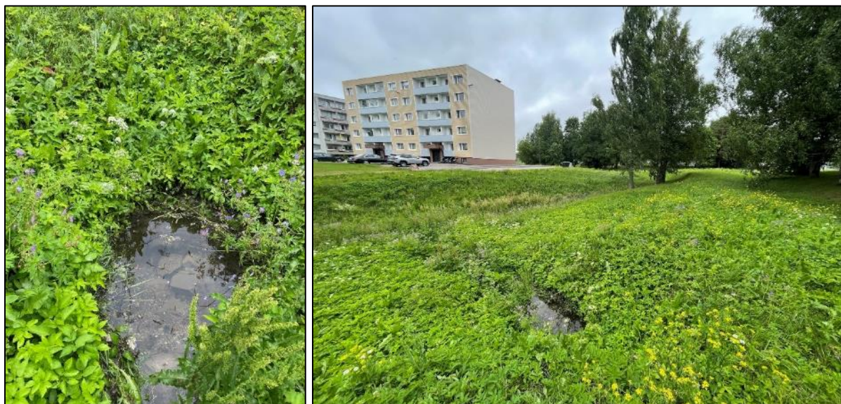
Pilt 2. Kelgumäe tn 2 kraav ja Vabaduse ringtee sademeveetorustiku väljavool kraavi.
