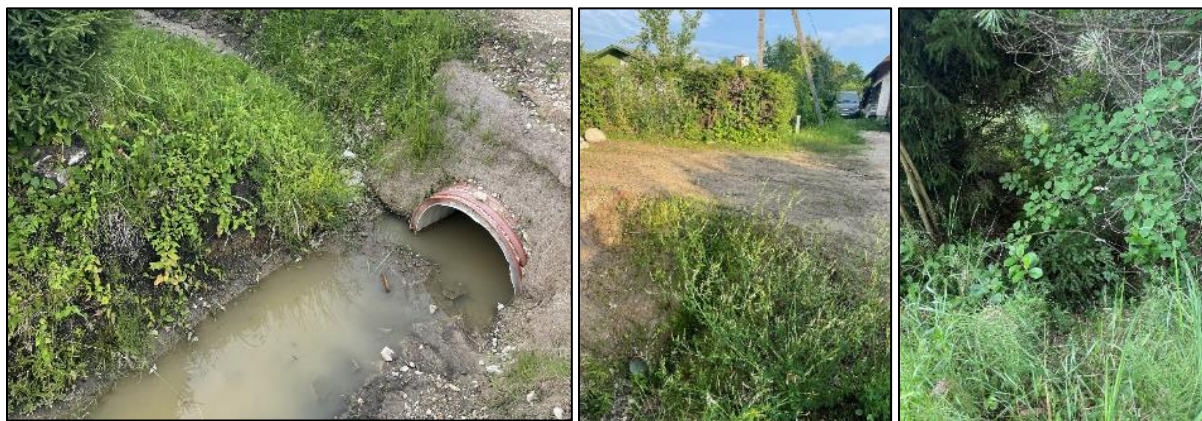
Pilt 5. Uputatud truup ja võsastunud kraav Tagakuusiku tn ja K22-K21 valgala ühendav aladimensioneeritud truup.
