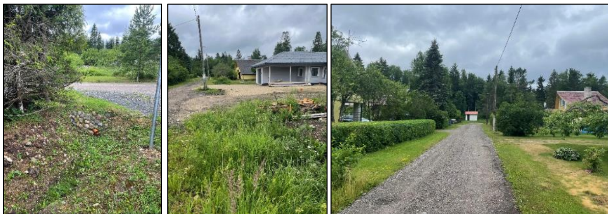
Pilt 11. Karmeni AÜ aladimensioneeritud truup, Toru põik uusarenduse käigus kinni aetud kraav ja puuduv kraavitus Kristalli tn.
