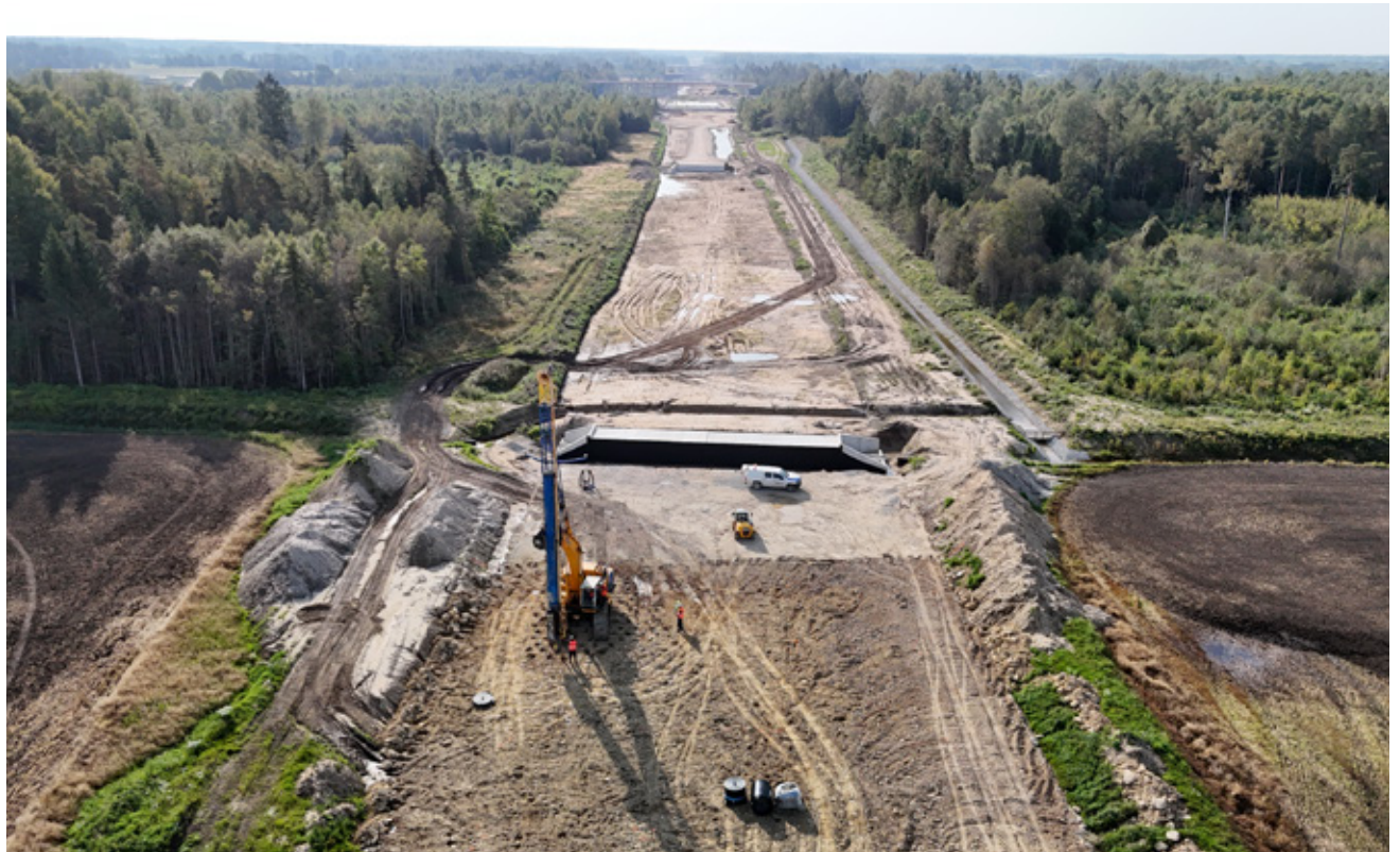
Kohila vallas kasutatakse Rail Baltica ehitusel liigniiske pinnase kuivendamiseks Eestis seni harva kasutatud vertikaaldrenaazi tehnoloogiat.
