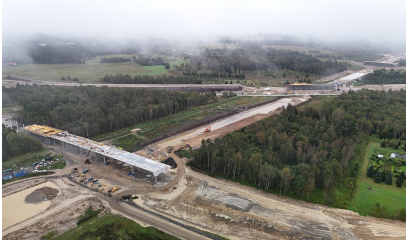
Esiplaanil Härjaoja maanteeviadukt, mis koosneb viaduktist ja kõrgetele postidele toetuvast estakaadist. Taamal paistavad Kohila viadukt, Salutaguse viadukt ja Kohila rohesild. Fotod: Verston Eesti
